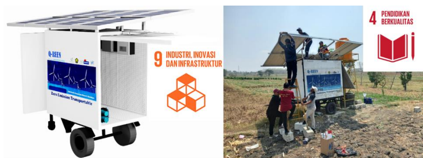
Gambar 5. Proses Pembongkaran Instalasi QREEN
